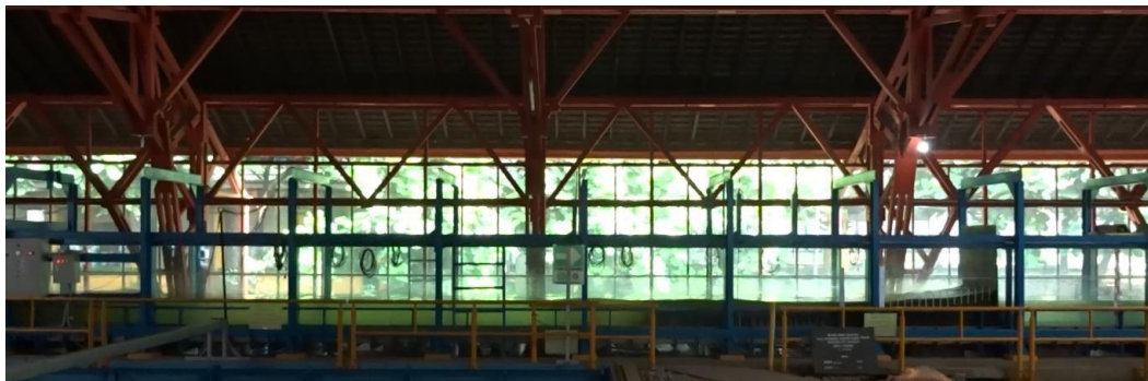
Gambar 13. Saluran Gelombang Lab Hidrodinamika ITB Sumber: Nurisman, N (2016)
