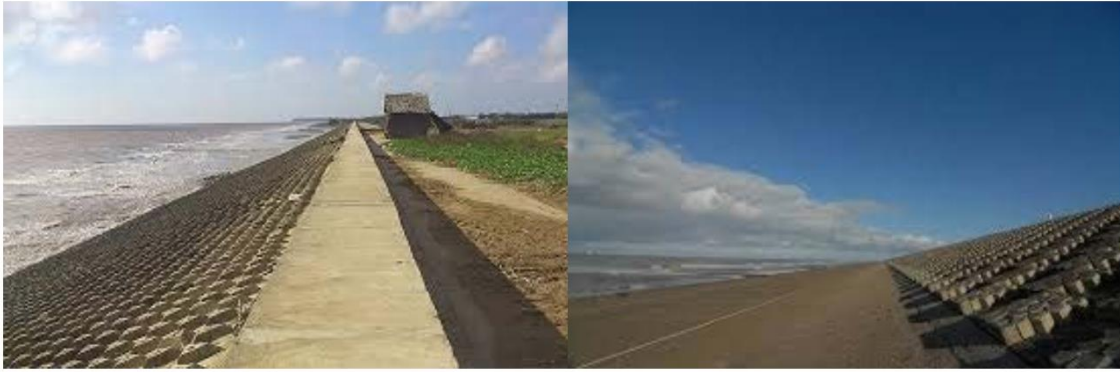
Gambar 7. Tembok Laut ( Seawall )
