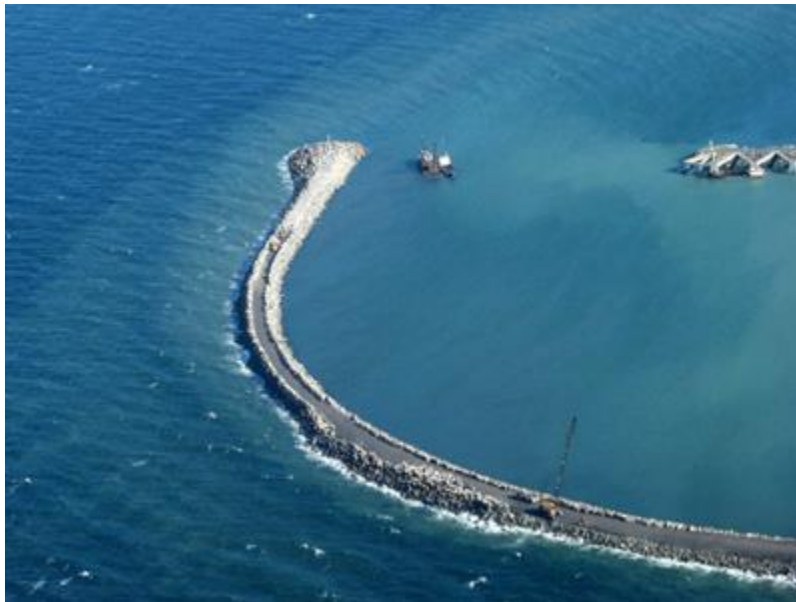
Gambar 9. Pemecah Gelombang ( Breakwater )
